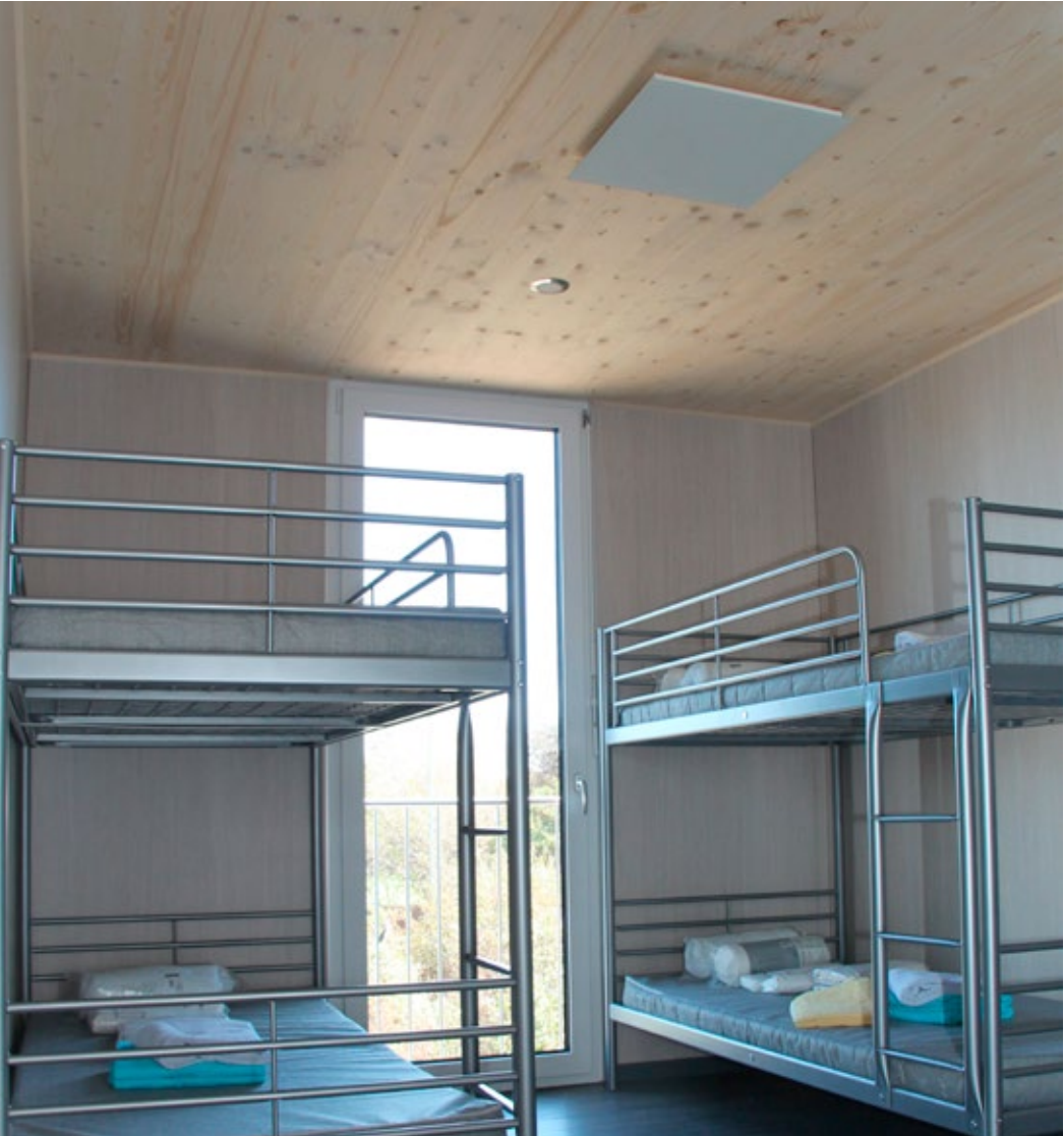
VH-Heizelement an der Decke montiert im Wohnheim.
