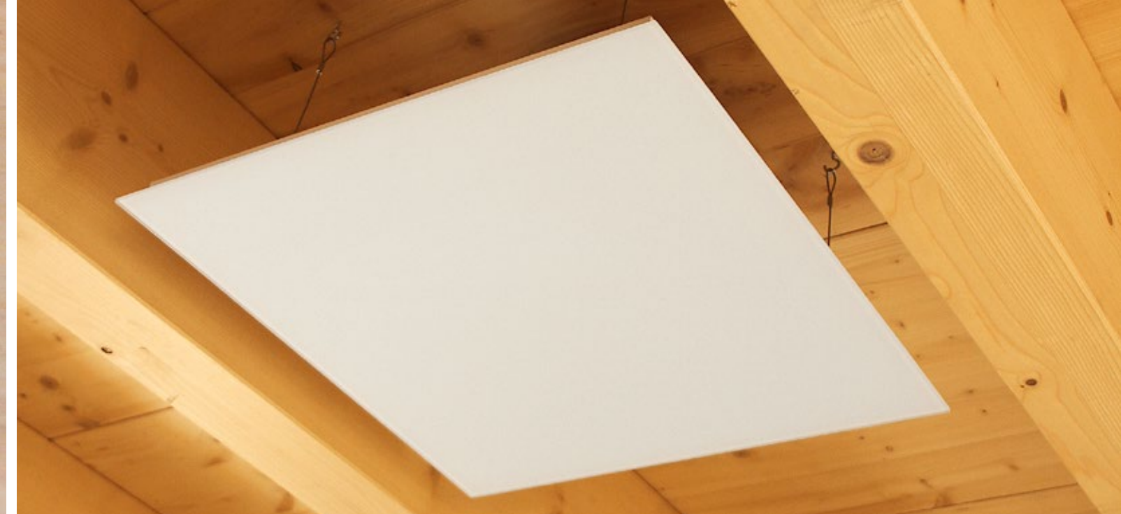
VH-Heizelement von der Decke abgehängt.
