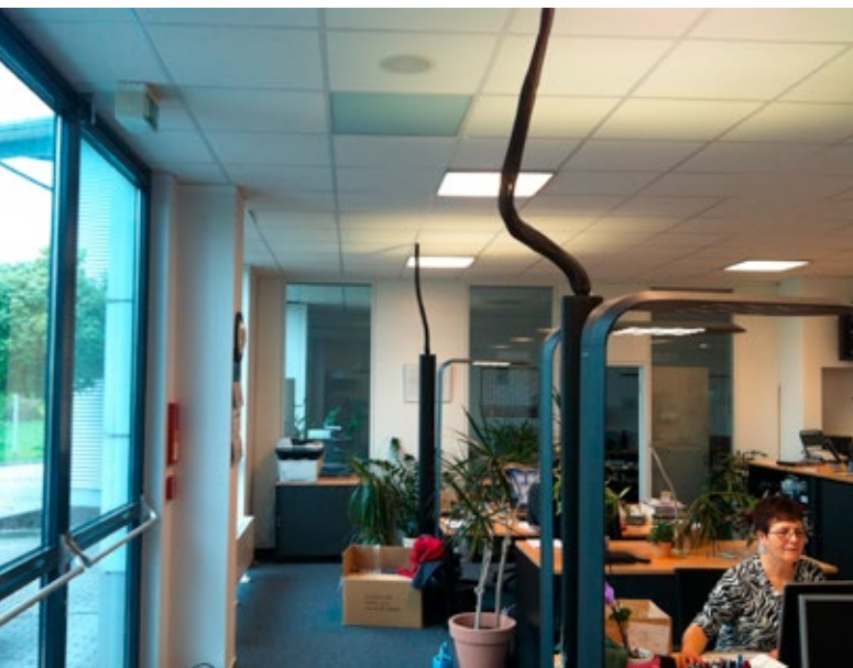
In die Systemdecke eingelegtes Heizelement der Baureihe VH.
