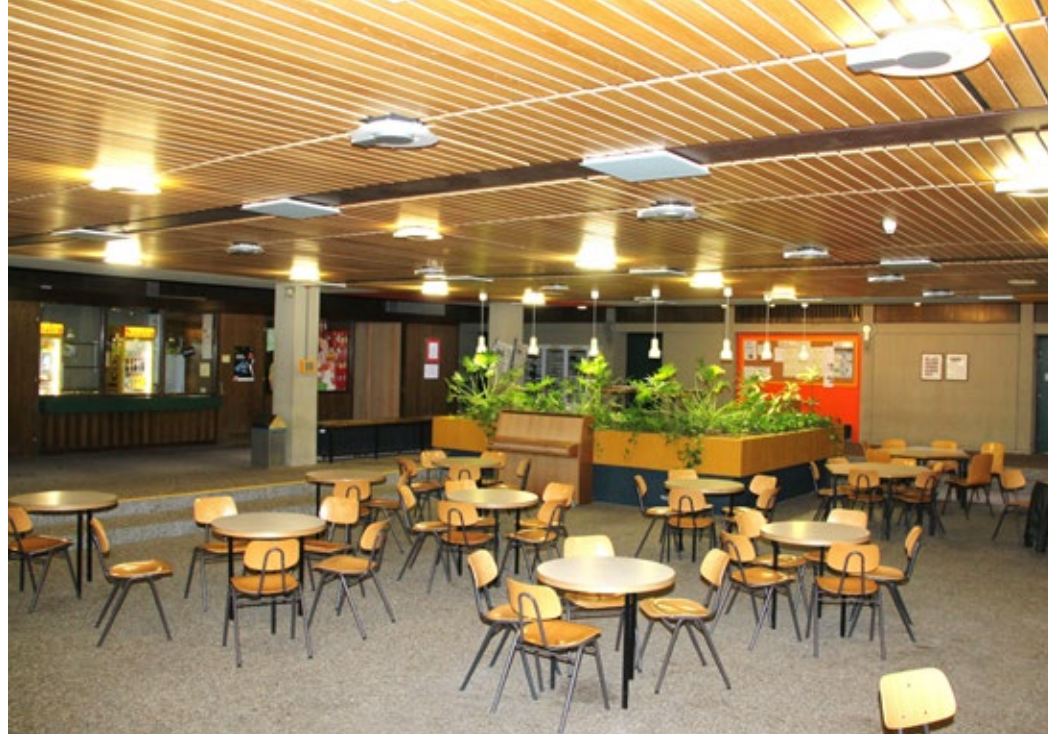
VH-Heizelement in einer Schulaula an der Decke montiert.
