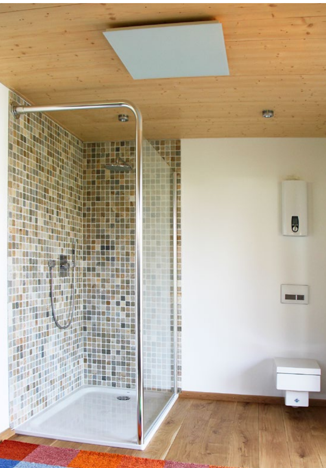
VH-Heizelement an der Decke montiert im Alt-und Neubau.
