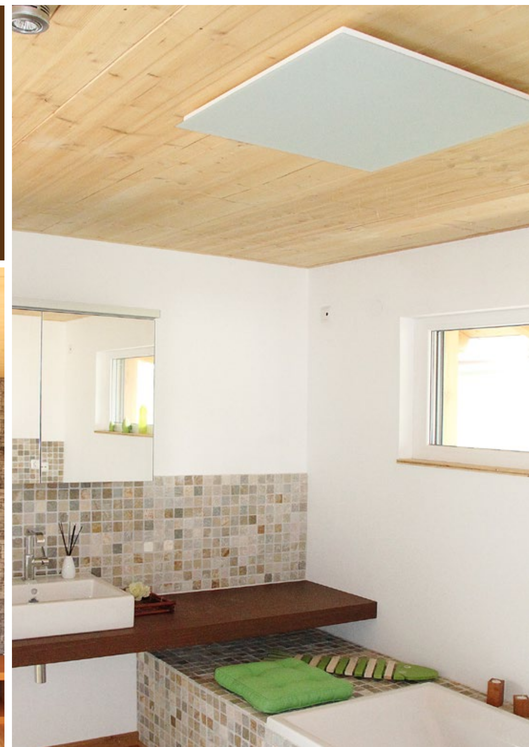
VH-Heizelement an der Decke montiert im Alt-und Neubau.
