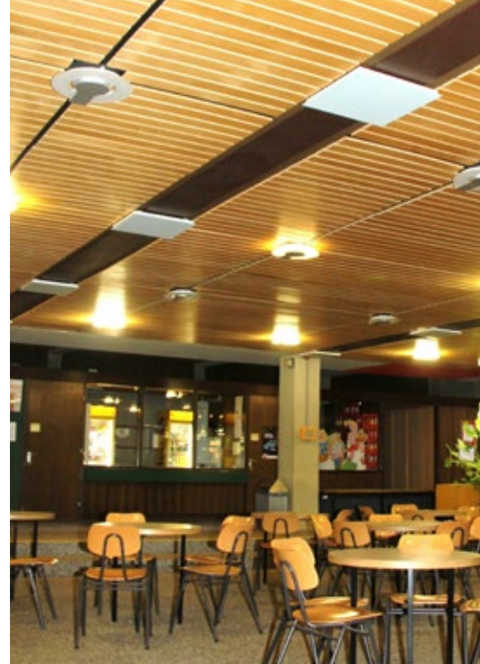
VH-Heizelement in einem Verkaufsraum an einer Traverse abgehängt.
